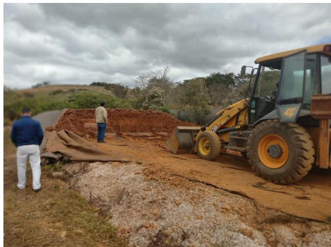
Figura 4 - Remoção do lodo do Geotube .
